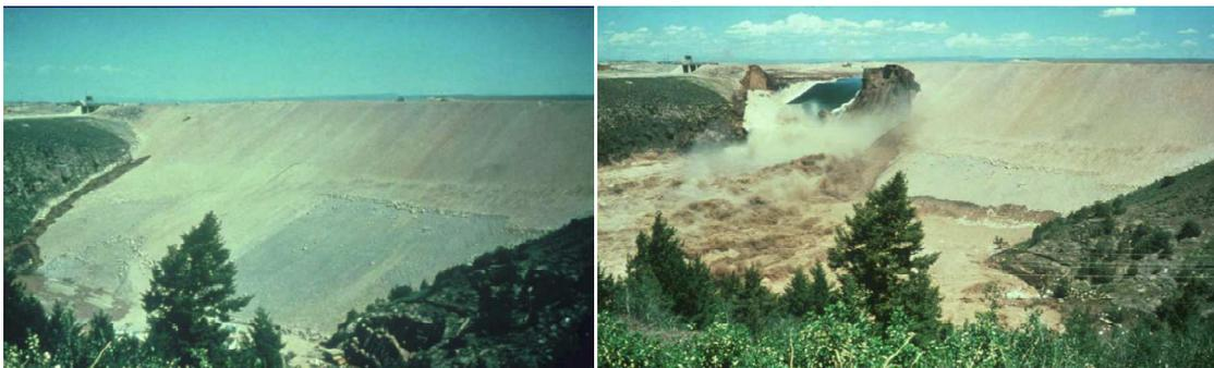
**Figure (IV.1) :** Exemple de rupture d'un barrage par érosion interne (Teton 1976)
