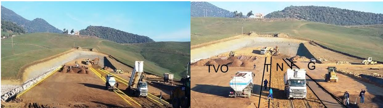
Figure (III.2): Image qui montre les différents matériaux composants de la digue
