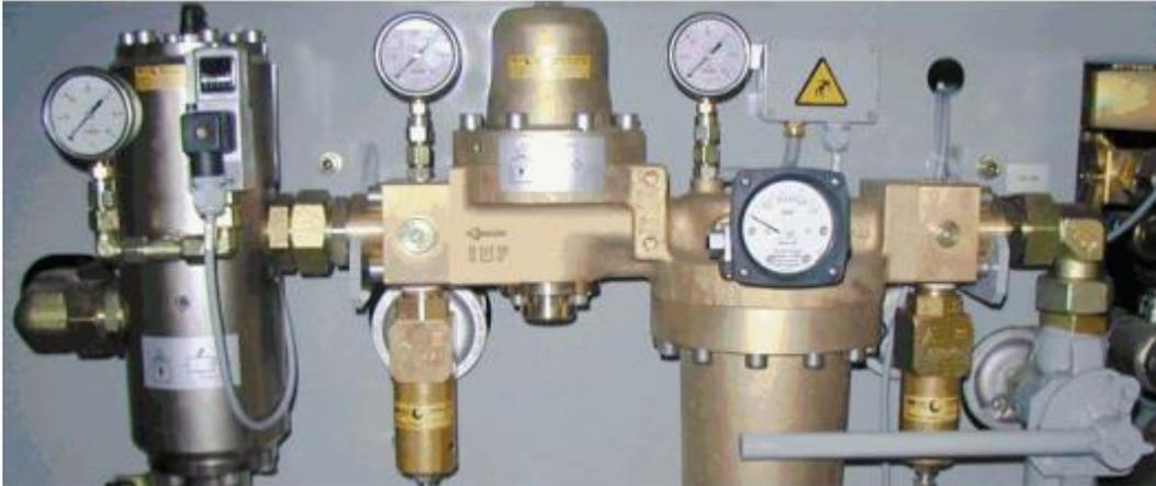
**Figure III.6 :** Tableau pneumatique haute pression
