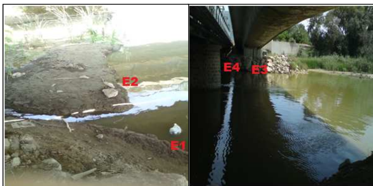
Figure III.2 : Photographie du site d'étude au dessous du pont de Bougie.
