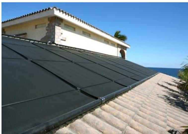
**Figure II.12 :** Capture plan non vitré. [22]
