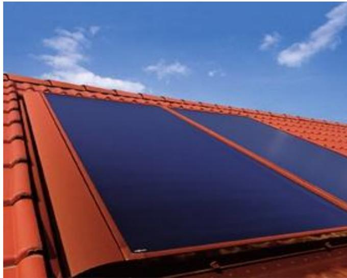
**Figure II.11 :** Capture plan vitrés. [22]
