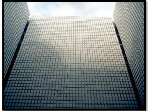
Figure III-11 : Mur du patio.
