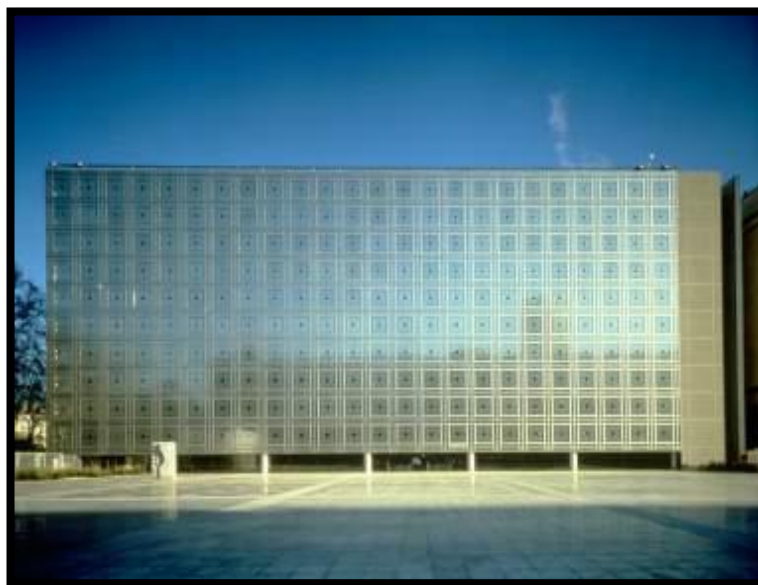
Figure III-1 : Institut du monde arabe. Source: http://www.greatbuildings.com
