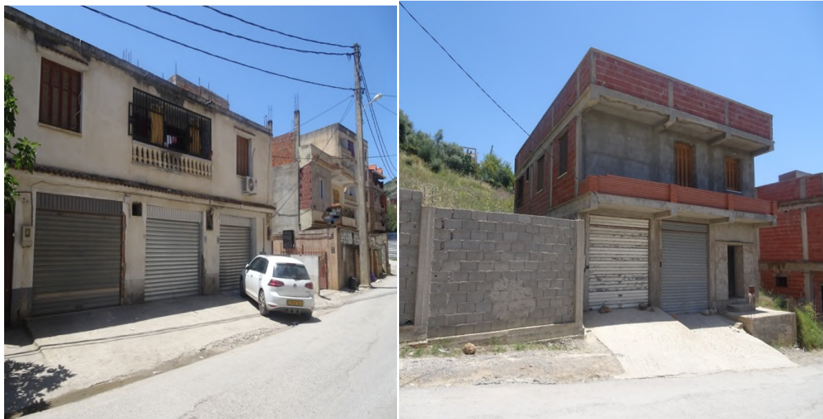
Figure 48: Les habitations auto-construites du quartier Targa Ouzemour.
