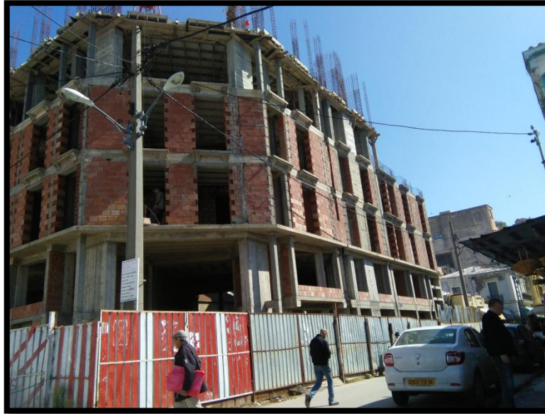
Figure n°4-11 : habitat collectif en cours de construction
