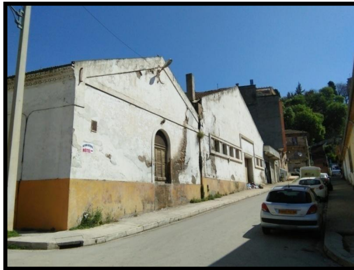
Figure n°4-16 : bâtiment industriel de l'époque coloniale
