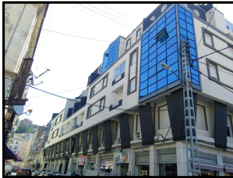
Figure n°4-9 : habitat collectif présent sur site
