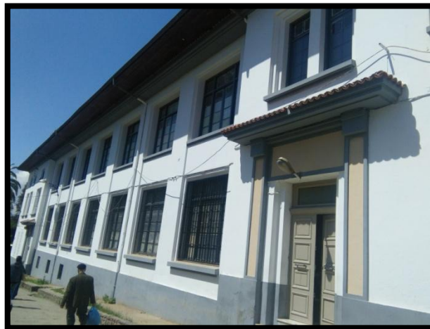
Figure n°4-24 : vue sur la façade de l'école primaire AZZOUG AHMED FILLES
