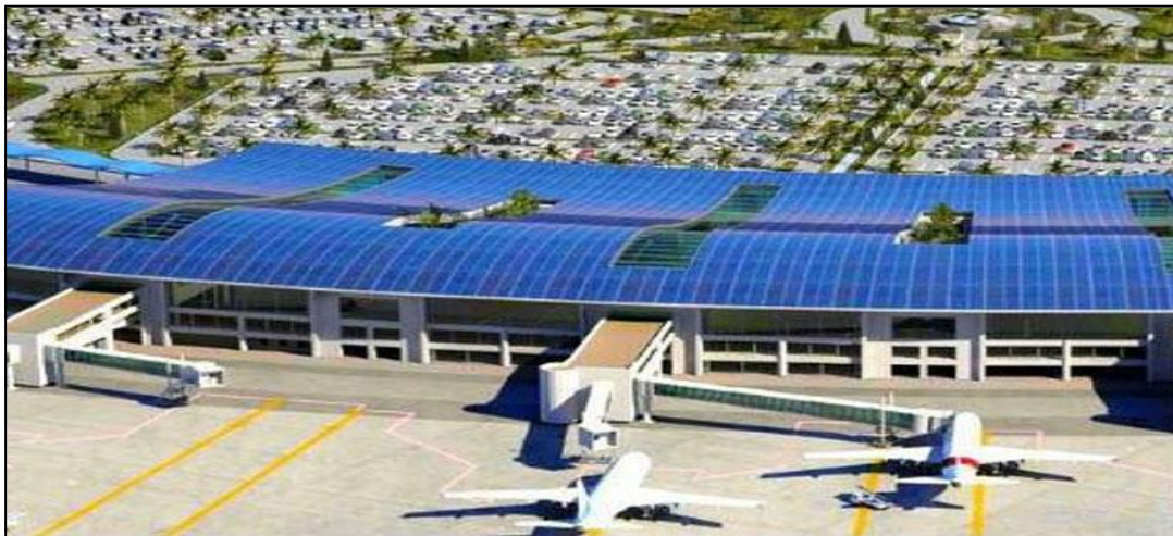
Figure I.5 : Centrale photovoltaïque à l'Aérogare d'Oran.
