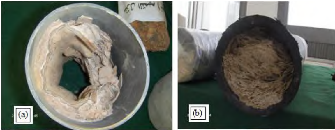
Figure A.II.5. Photos des dépôts de tartre de carbonate de calcium dans la canalisation métallique (a) et non métallique (b) [8].
