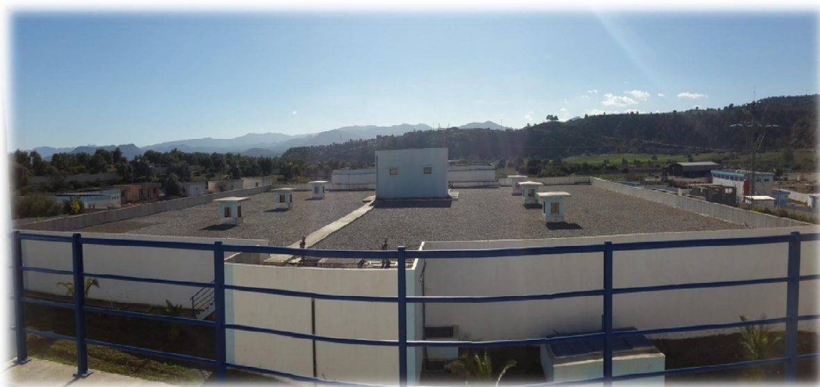
Figure III.14 : Réservoir d'eau traitée (station du barrage Tilesdit)
