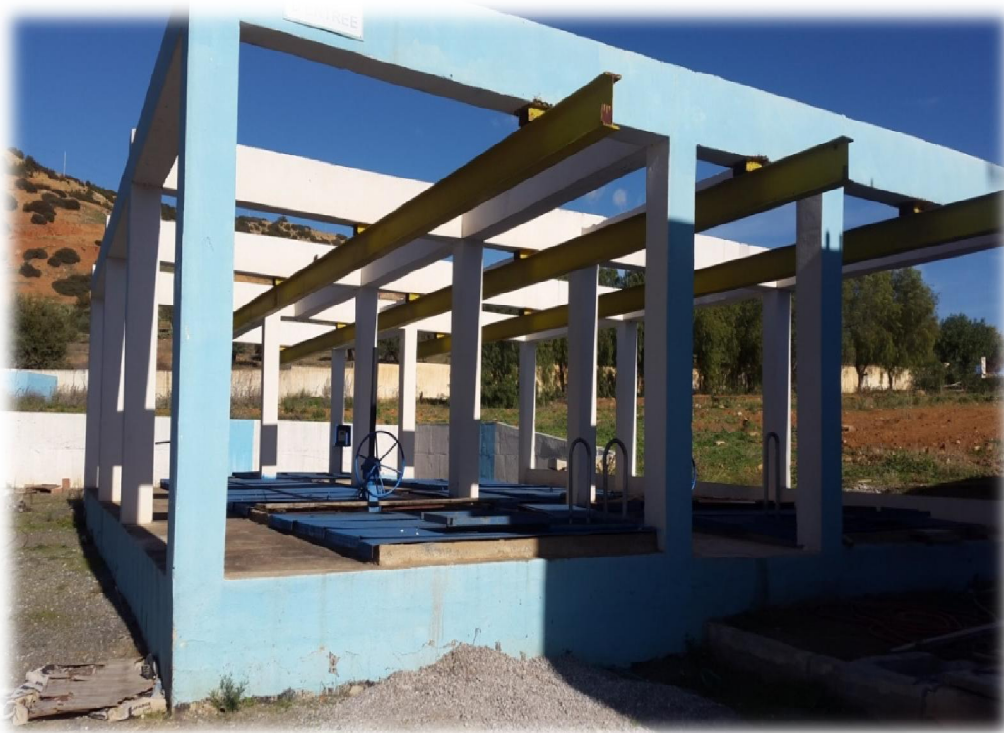
Figure III.2 : l'ouvrage d'entrée (station du barrage TILES DIT)
