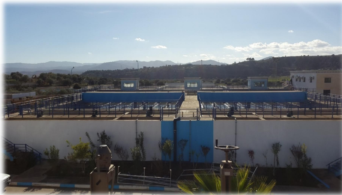
Figure III.5 : Le clarificateur (station du barrage Tilesdit)
