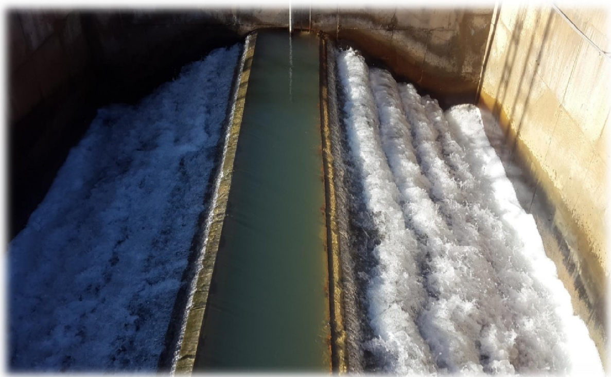
Figure III.3 : La cascade d'aération (station du barrage Tilesdit)
