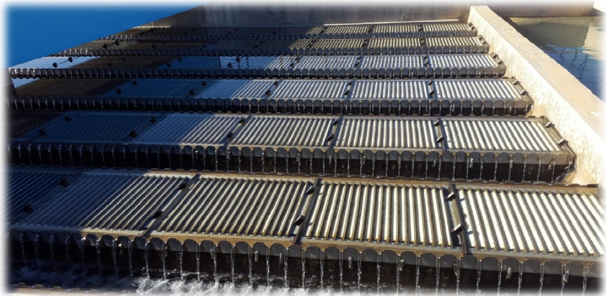
Figure III.10 : système lamellaire (station du barrage Tilesdit).
