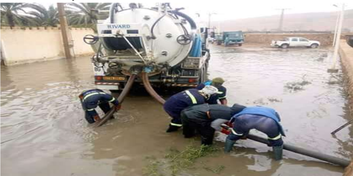
Fig. (III.9) III.09 curage avec l'hydromécanique
