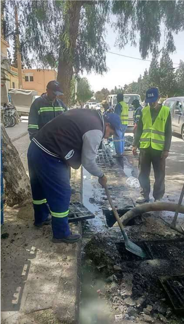
Fig. (6) III.6 curage mécanique et manuel source ona
