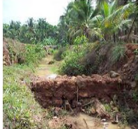
b) Barrière en enrochement.
