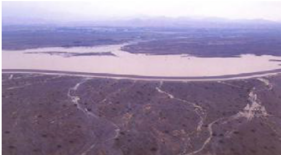
Figure (III.5): Inondation à partir du barrage Al Khoud (Sultanat d'Oman) pour la recharge artificielle de la nappe alluviale.
