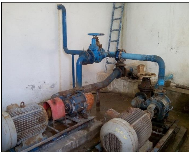
Photo 12 : Axes d'aspiration des pompes placés au-dessus du radier
