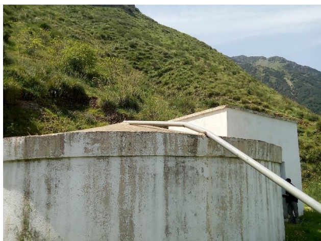
Photo 19 : L'entrée de la conduite d'adduction (SRI-RV.A) dans le réservoir
