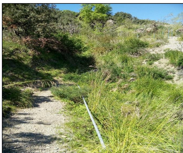
Photo 05 : Conduites apparentes dans des accotements
