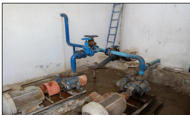
Photo 08 : L'intérieur de la salle de machine non entretenue de la SP
