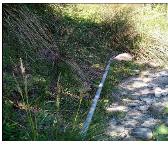
Photo 05 : Conduites apparentes dans des accotements
