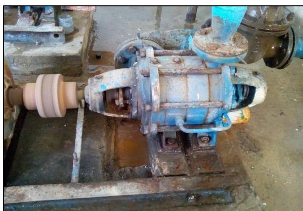
Photo 09 : Dégradation des deux GEP c'est pourquoi on remarque des fuites d'eau
