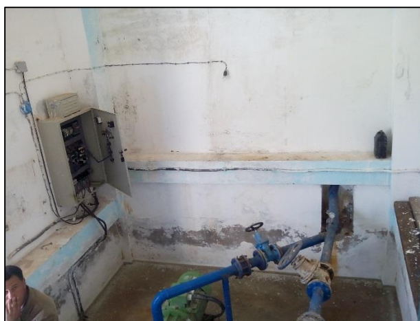
Photo 15 : - Des installations électriques à l'intérieur de la chambre des équipements hydromécaniques de la SR1 et des fuites d'eau au niveau des joints
