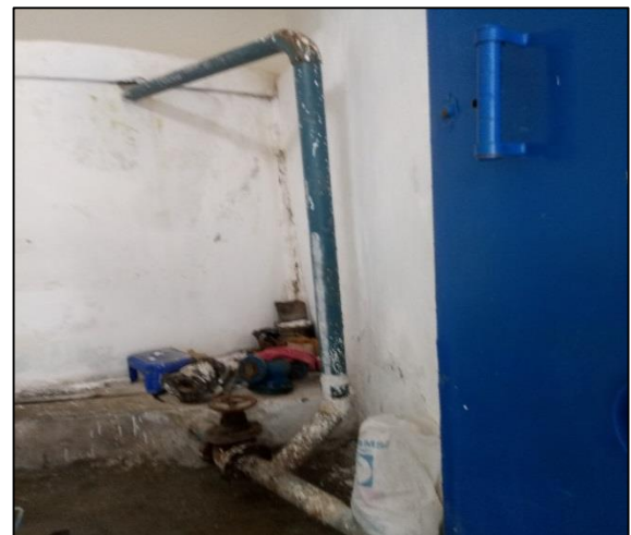
Photo 12 : Axes d'aspiration des pompes placés au-dessus du radier
