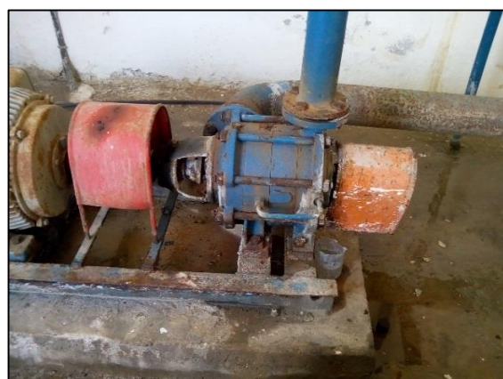
Photo 09 : Dégradation des deux GEP c'est pourquoi on remarque des fuites d'eau
