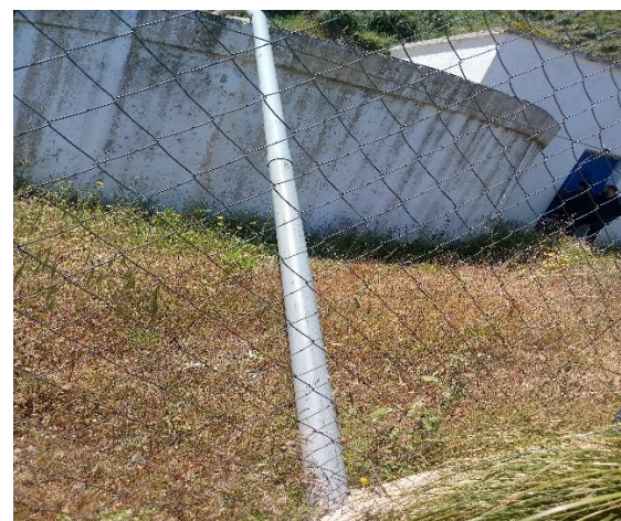
Photo 19 : L'entrée de la conduite d'adduction (SRI-RV.A) dans le réservoir
