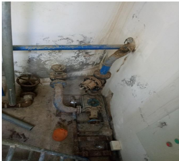
Photo 27 : Le GEP et la pompe immergée de la SR2
