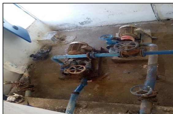
Photo 08 : L'intérieur de la salle de machine non entretenue de la SP
