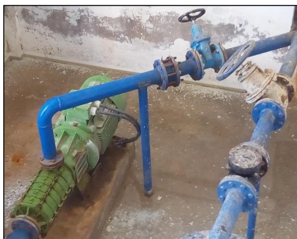
Photo 15 : - Des installations électriques à l'intérieur de la chambre des équipements hydromécaniques de la SR1 et des fuites d'eau au niveau des joints
