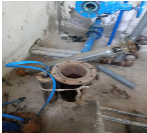
Photo 27 : Le GEP et la pompe immergée de la SR2
