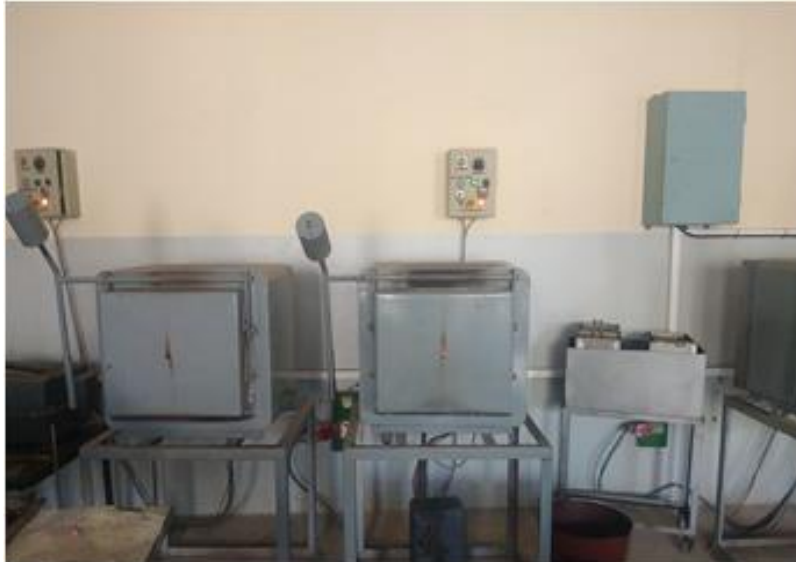
Figure II.8: les fours de traitement thermiques.
