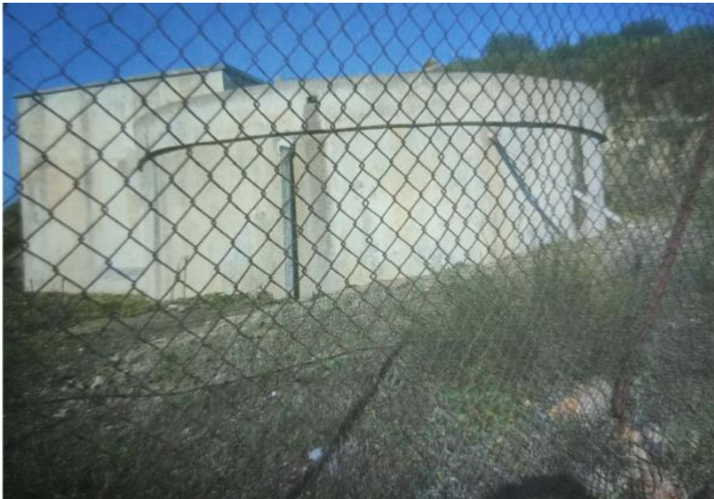
Photo 02 : Vue de profil du réservoir Iakouchene
