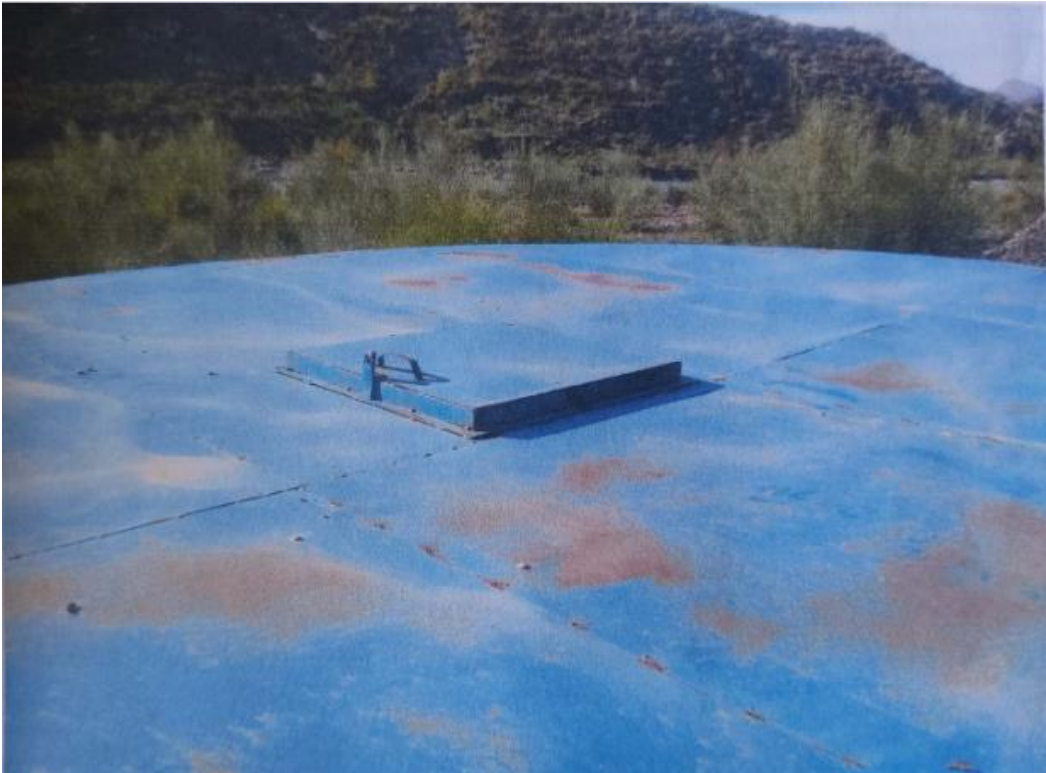
Photo 12 : Vue sur la trappe d'accès, le capot de couverture du puits
