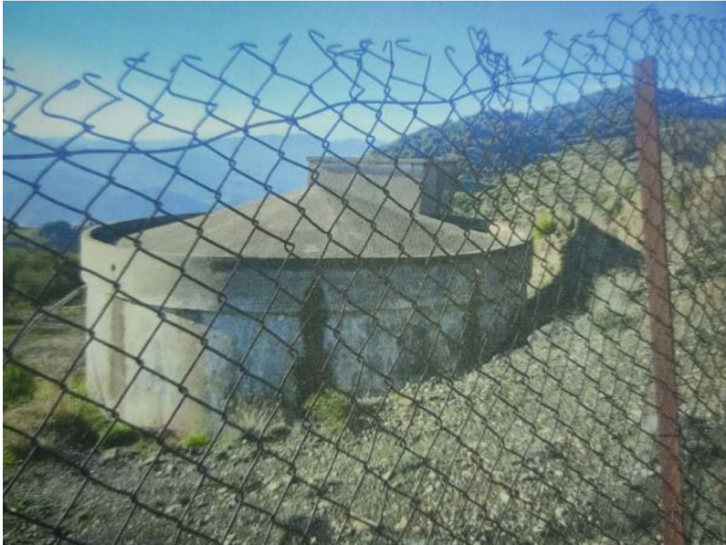
Photo 03 : Vue de dessus du réservoir Iakouchene
