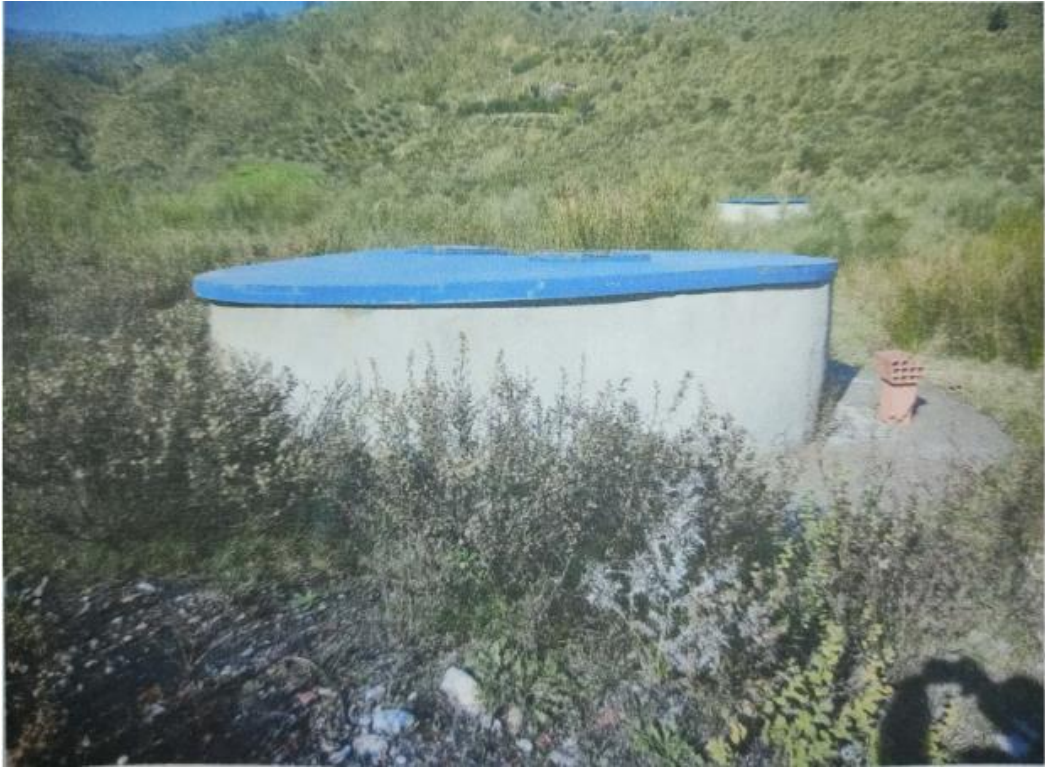
Photo 07 : Vue d'ensemble sur le puits 2
