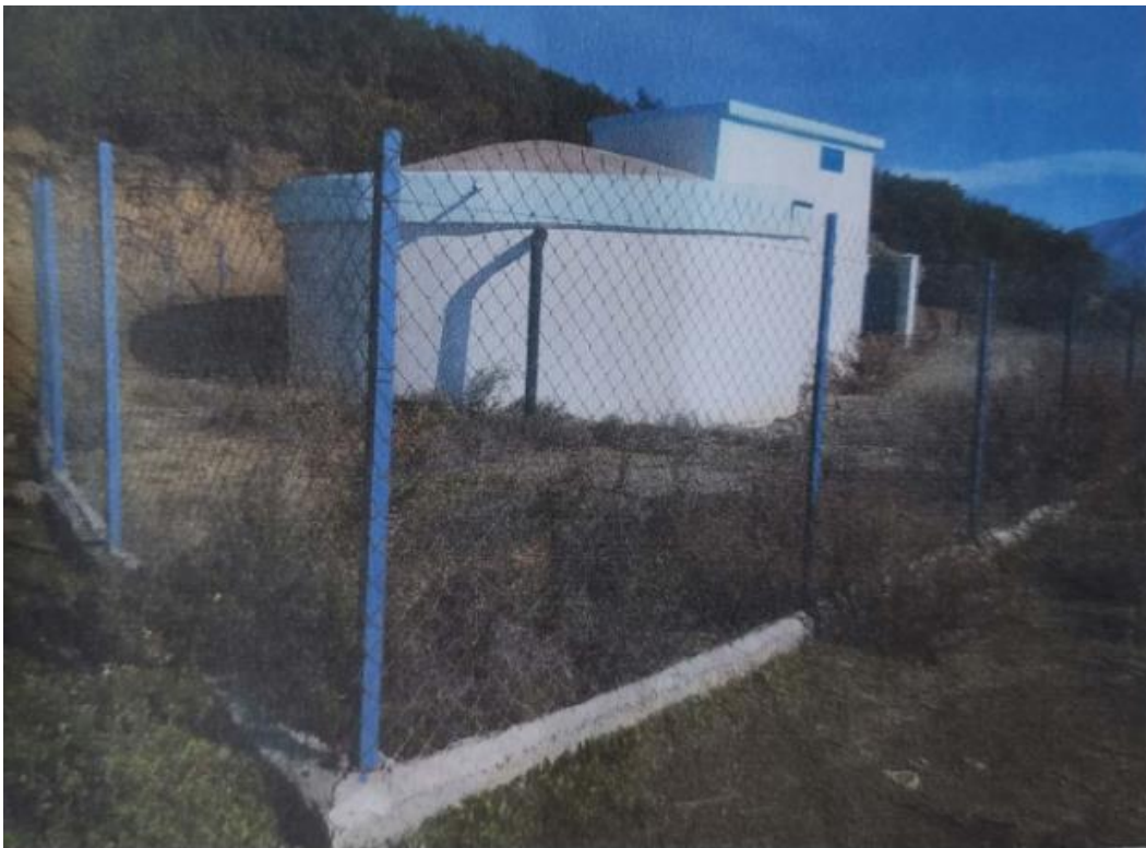
Photo 16 : Vue sur réservoir Iafar
