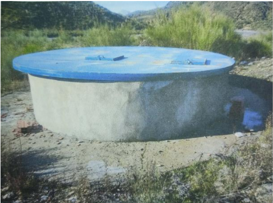
Photo 06 : Vue d'ensemble sur le puits 1
