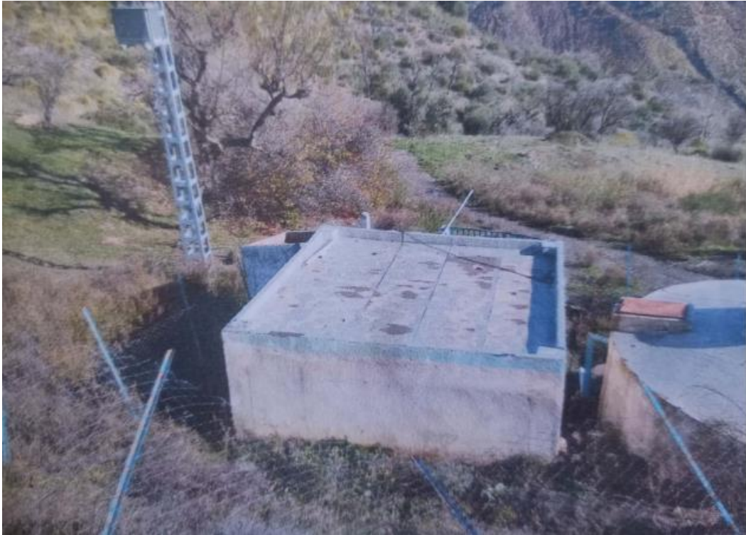
Photo 15 : Vue latérale Ouest sur la station de reprise de Sebouka
