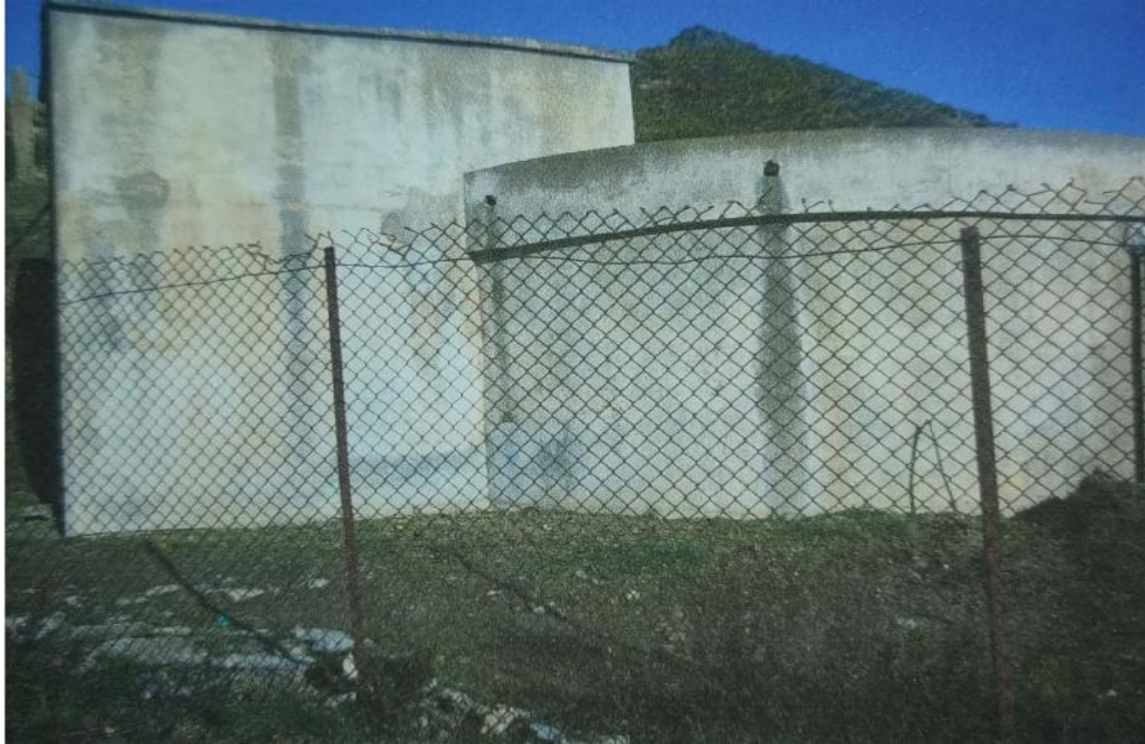
Photo 01 : Vue de profil du réservoir Iakouchene
