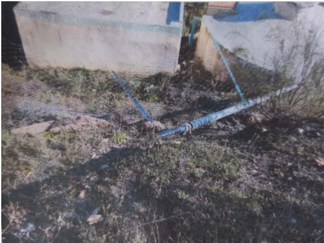
Photo 14 : Vue latérale Ouest sur la station de reprise de Sebouka
