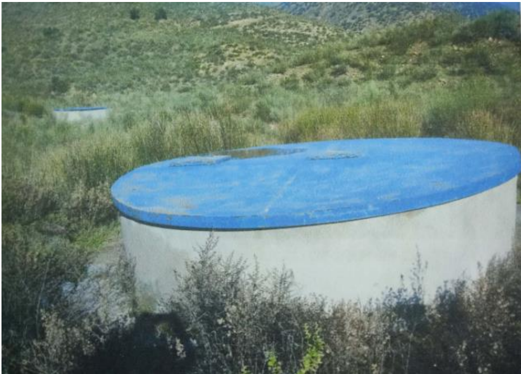
Photo 08 : Vue d'ensemble sur les deux puits
