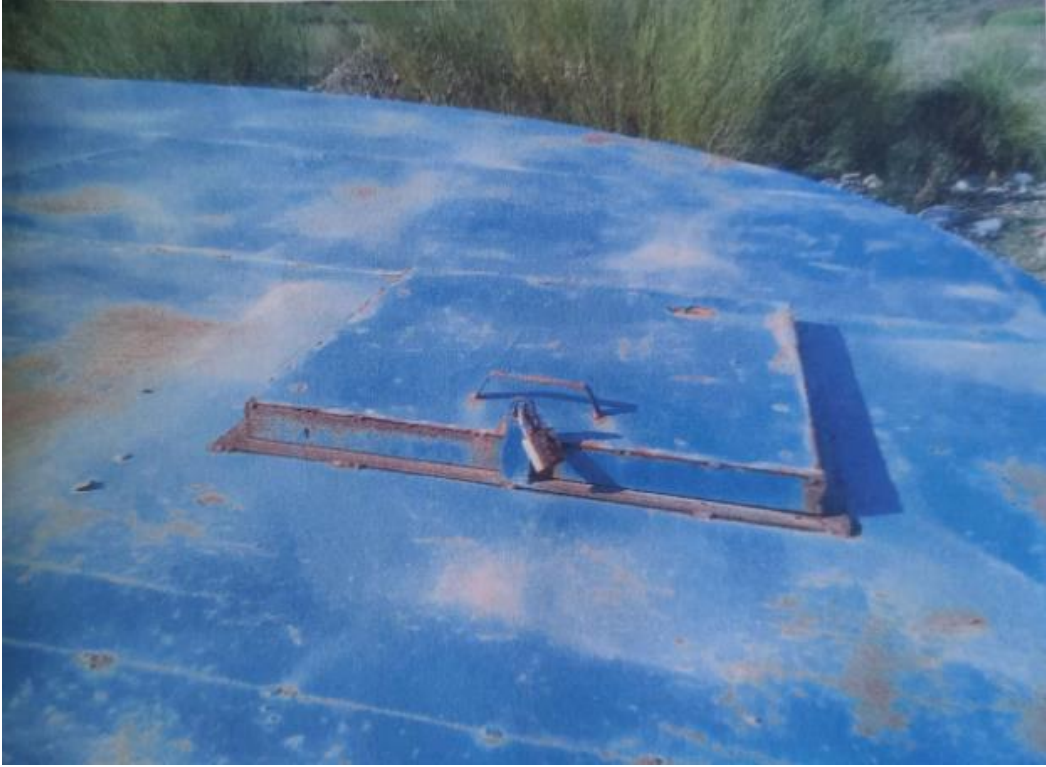
Photo 11 : Vue sur la trappe d'accès, le capot de couverture du puits
