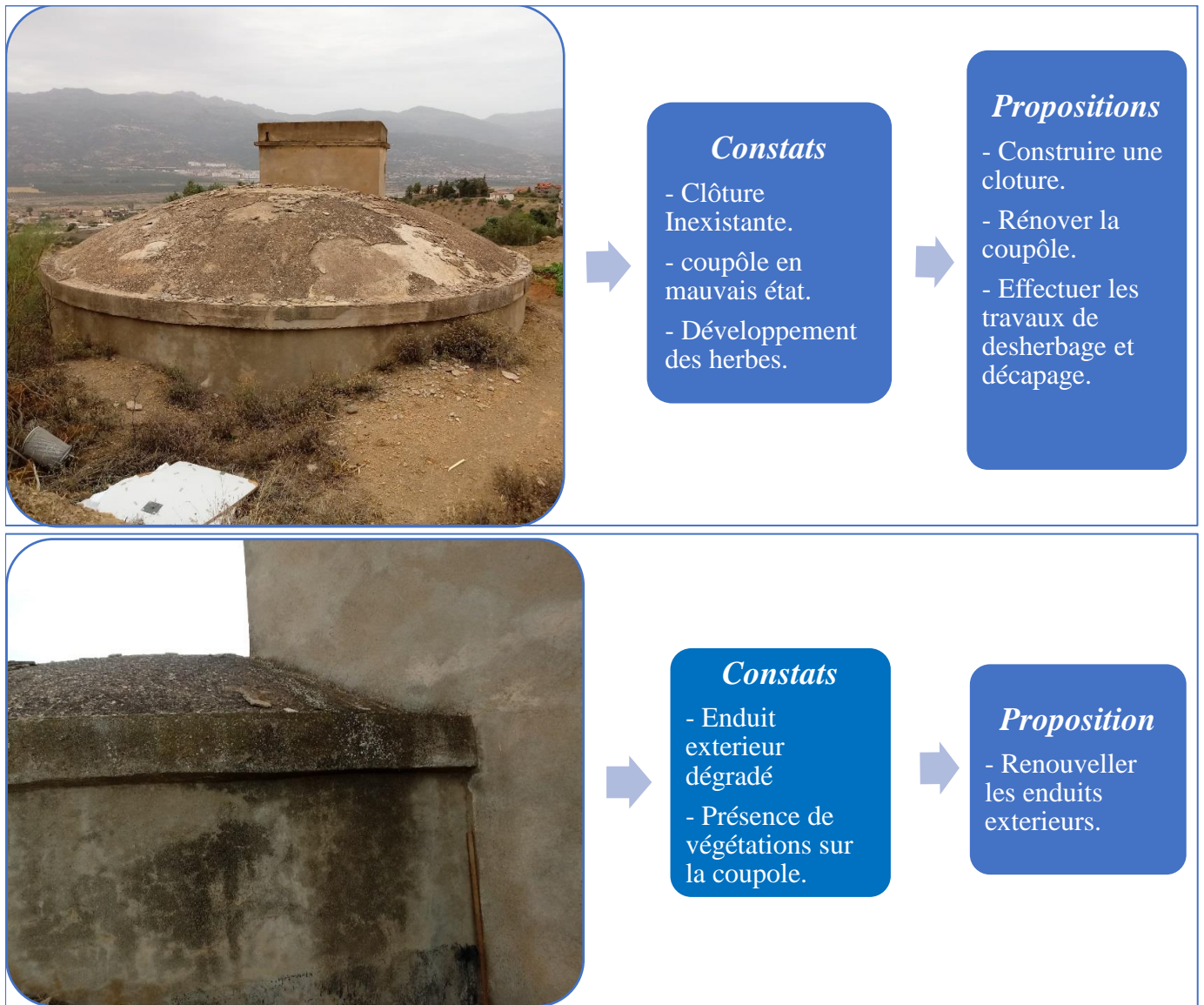
Figure (II-9) : Vue extérieure du réservoir de Thafazarth
