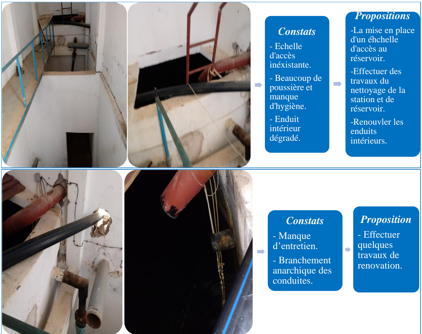
Figure (II-5) : Vue intérieur du réservoir de la SR2(B) d'Ouzouaghen
