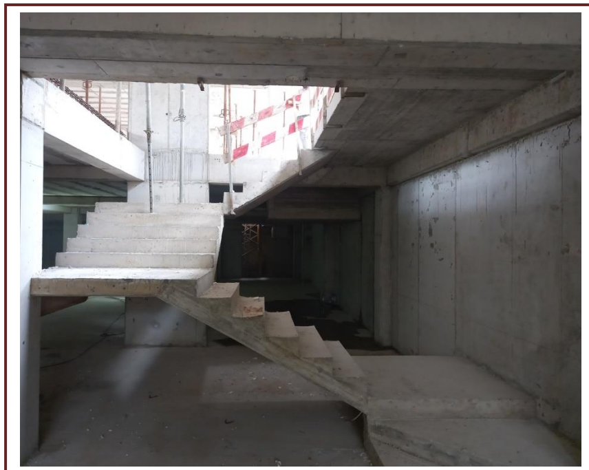
Figure I. 9. Photo réelle de l'escalier sous sol
