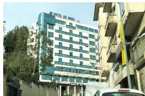
Figure 141: L'hôtel du Nord a Bejaia.(existant) Source : https://vymaps.com
