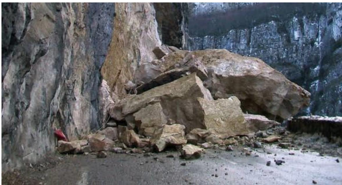
**Figure I.16 :** Exemple d'éroulement rocheux. [07]
