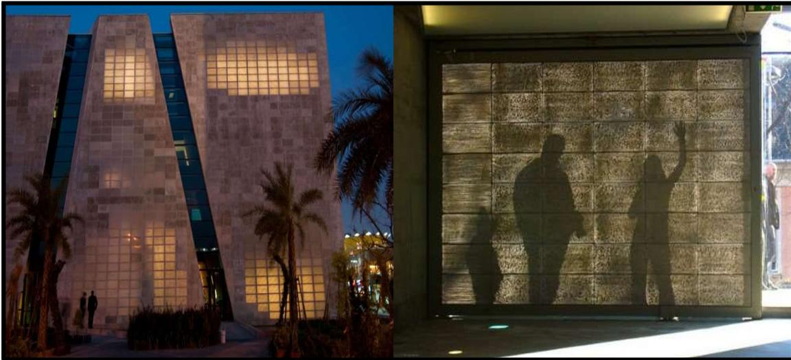
Figure II-24: Jeu d'ombre et de lumière à travers le béton translucide.
