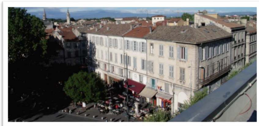
Figure 13: Nouvelle vie pour un quartier dégradé, Amélioration de l'habitat insalubre à Philonarde, Avignon (France), Source : Réhabimed, Expériences de réhabilitation méditerranéennes
