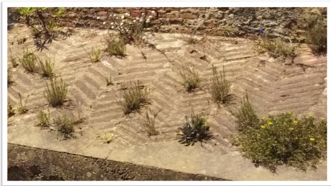
Figure 60: Vue sur le revêtement posé en épis. Source : Photo prise par l'auteure le 09/05/2022
