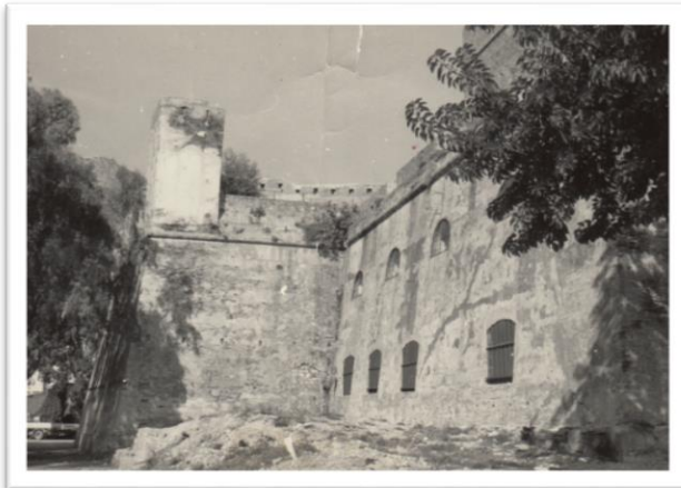
Figure 68: Vue sur la façade est montrant la position des ouvertures. Source : OGEBC Bejaia
