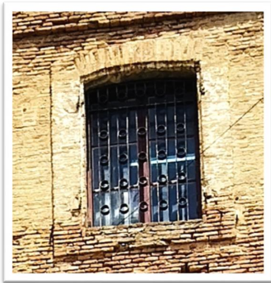
Figure 61: Ouverture en forme d'arc surbaissé de l'époque française. Source : Photo prise par l'auteure le 09/05/2022
