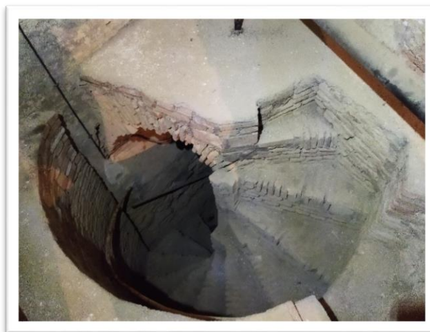
Figure 82: Vue sur l'escalier qui mene vers le sous-sol.
