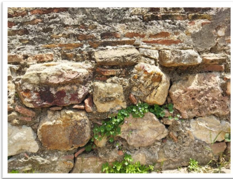
Figure 56: Vue sur l'appareillage constituant le soubassement. Source : Photo prise par l'auteure le 09/05/2022
