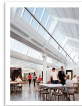
Figure 287: Toiture en sheds,
