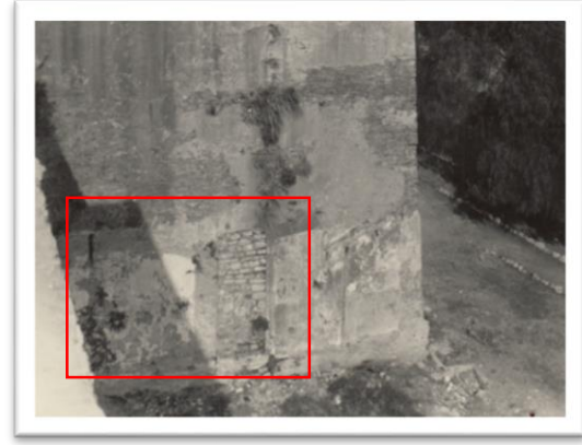
Figure 71: Traces des ouvertures fermées au bastion est du fort.
