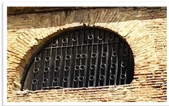
Figure 63: Ouverture en forme d'arc en plein cintre d'époque espagnole. Source : Photo prise par l'auteure le 09/05/2022
