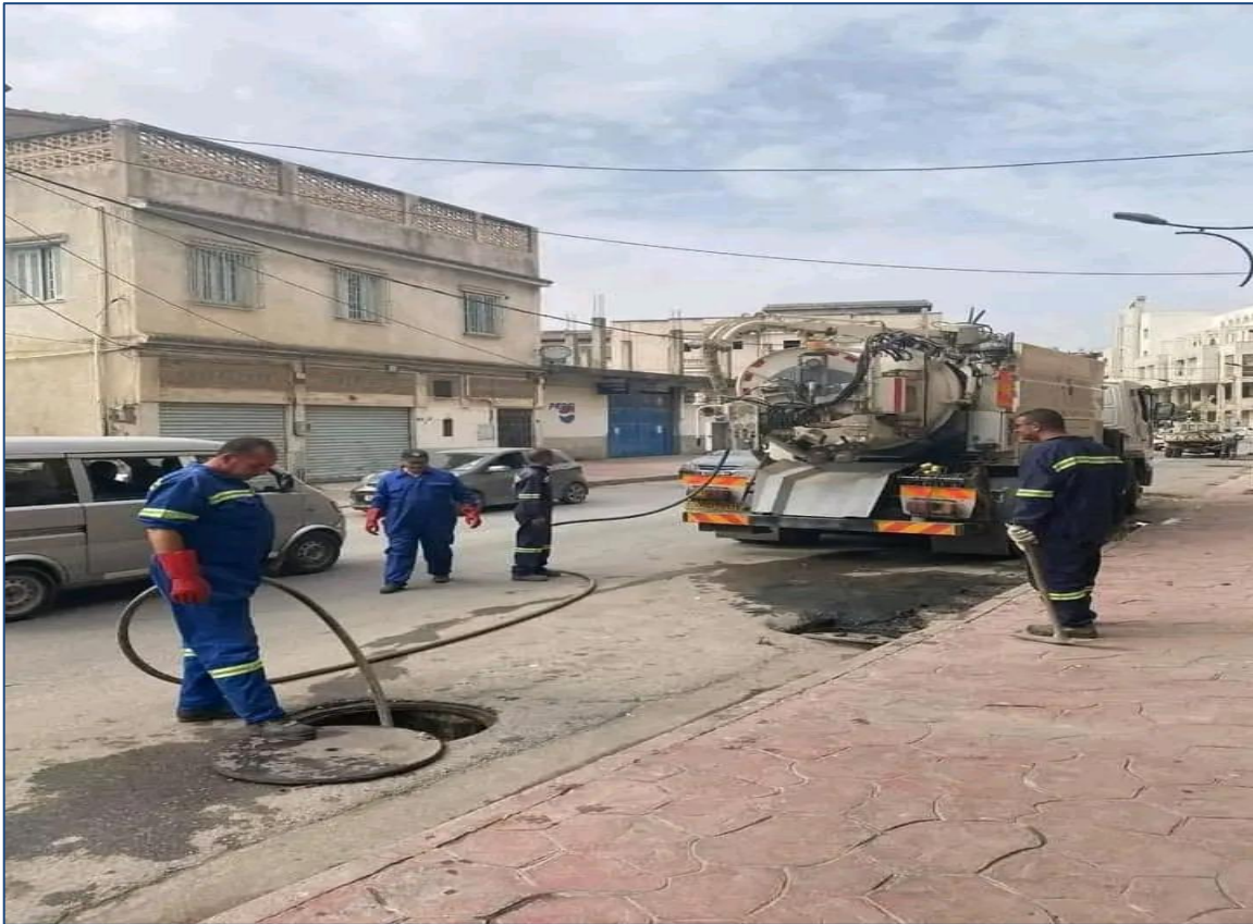
Figure (III-03) : Curage hydromécanique.
