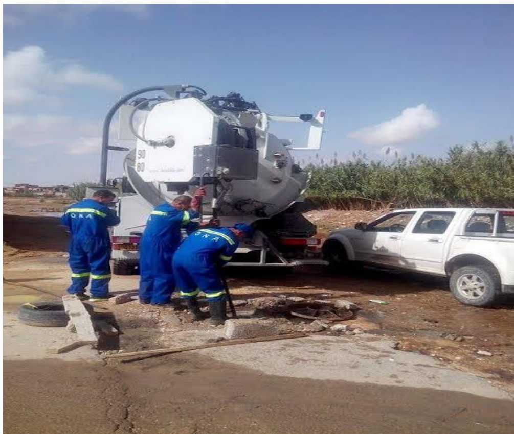
Figure (III-07) : Curage hydromécanique.
