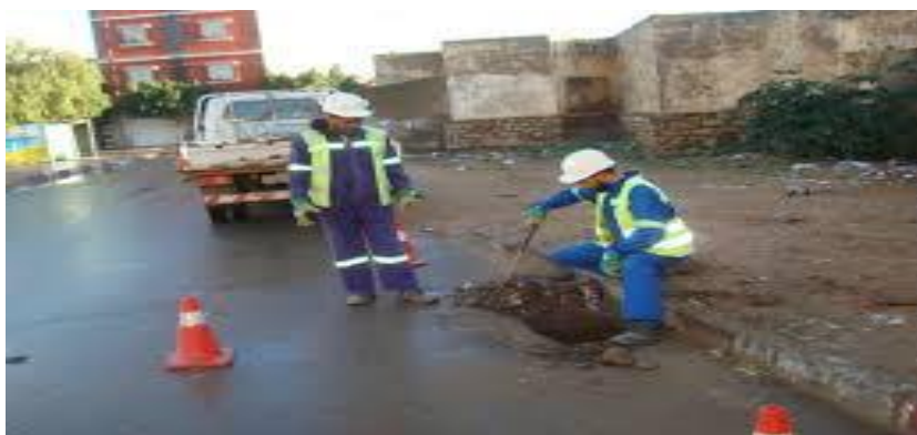
Figure (I.07) : Curage manuel par les agents de l'office national de l'assainissement.
