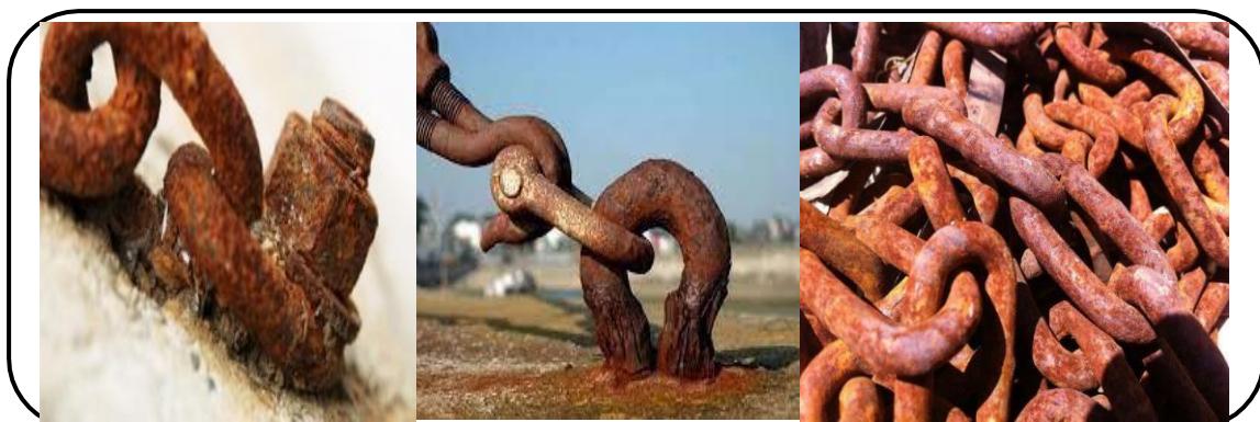
Figure I.6: Corrosion uniforme (généralisée) [11].
