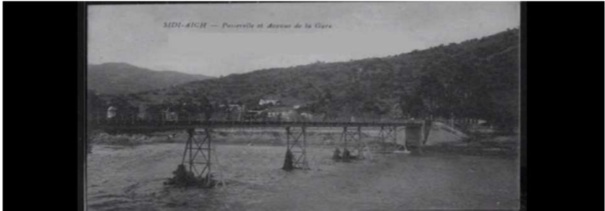
Pont de la Soumam
