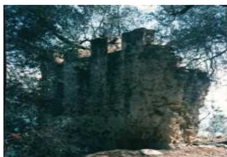
Figure 14 : Vue d'un pan de la muraille de la période médiévale encore debout
