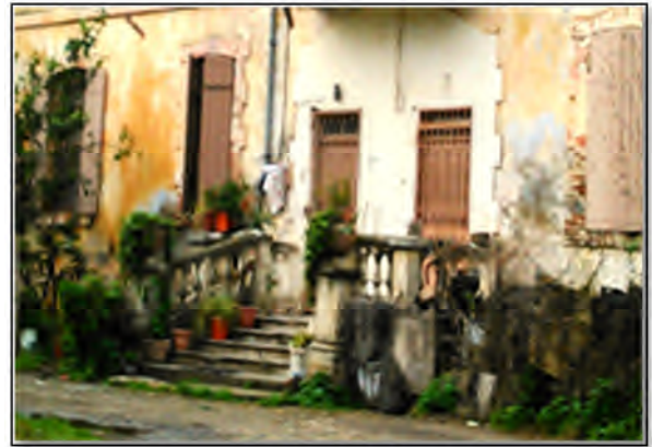
Photo 02 : Escalier de la façade principale, maison du maitre, ferme domaine Djebira.
