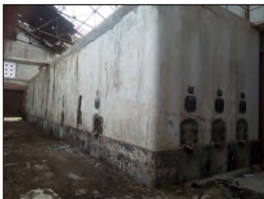
Photo 15 : Cuves parallélépipédique, Domaine, Djebel louze. Amizour.
