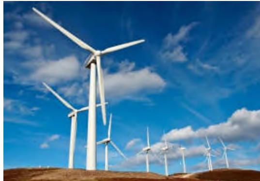
Figure II. 1 Éolienne utilisée dans production d'énergie électrique.
