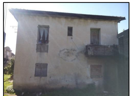
Figure 55: Détérioration du balcon de la façade latérale (Source : auteur)
