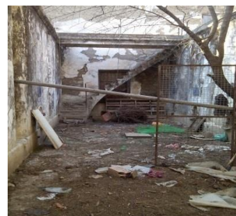
Figure 36 : dégradation très avancé de l'escalier ainsi que la prolifération de la corrosion des aciers.
