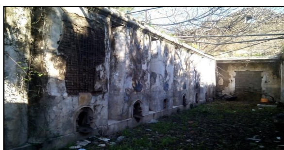
Figure 35 : dévoilement de la toiture de la cave Viticole et d'écoulement des revêtements suite à la végétation au long de la travée.
