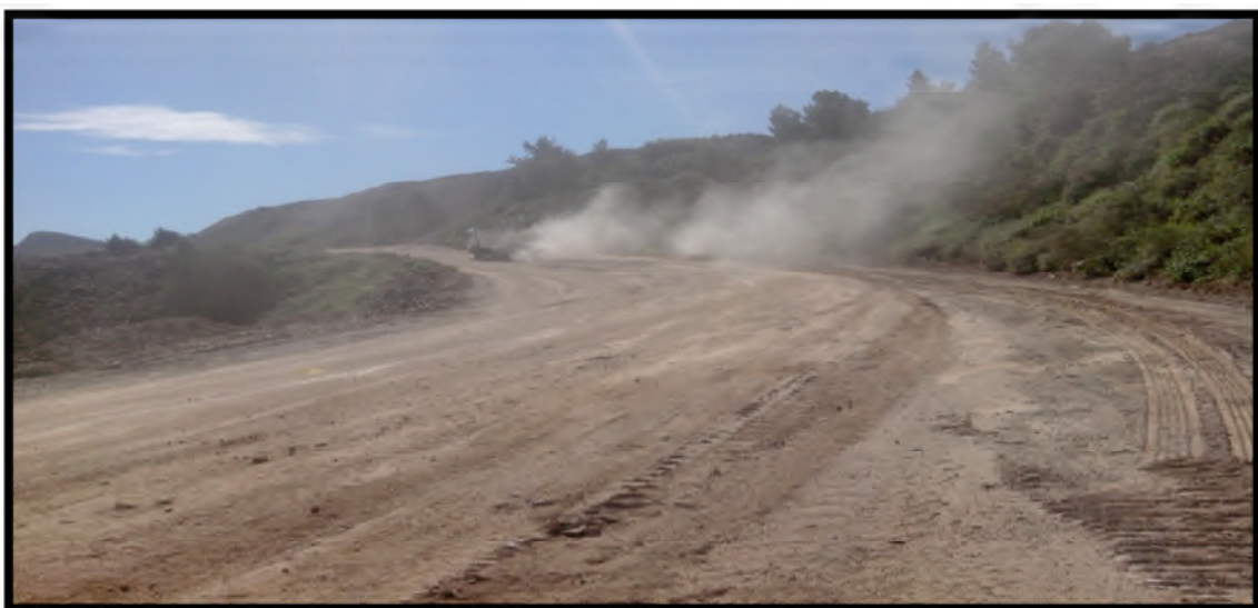
Figure II.1 : la largeur de la demi- tranchée d'accès (Adrar oufernou)
