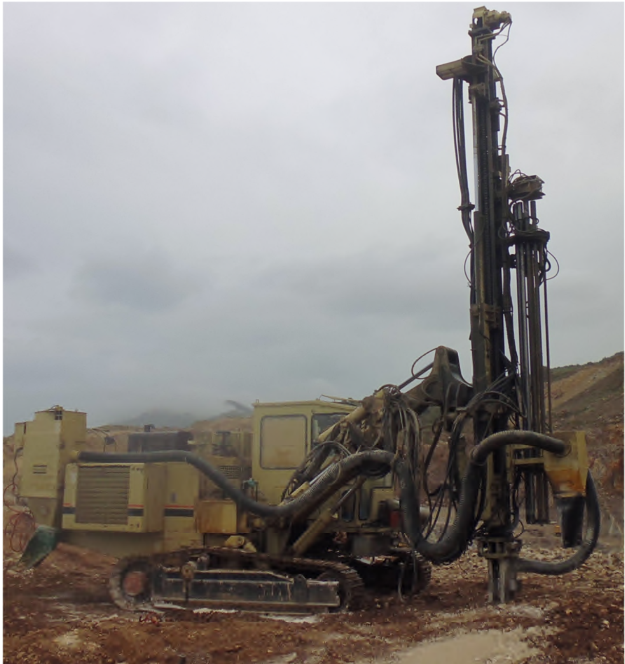
Figure III.1 : la sondeuse ATLAS COPCO 580Y
