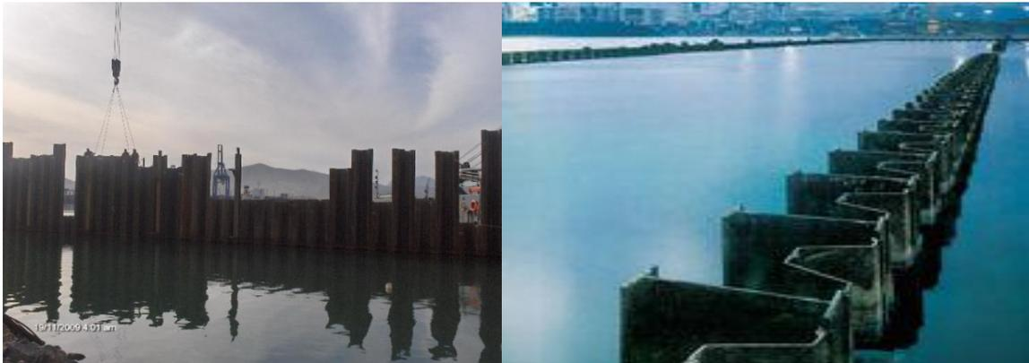
**Figure III.5 : Images pour des rideaux de palplanche type HZ/AZ au niveau du port de Béjaia.**
