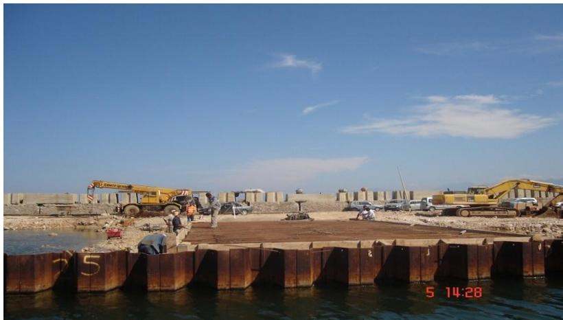
Figure III.2 : Images pour un soutènement des terres par un rideau de palplanche.
