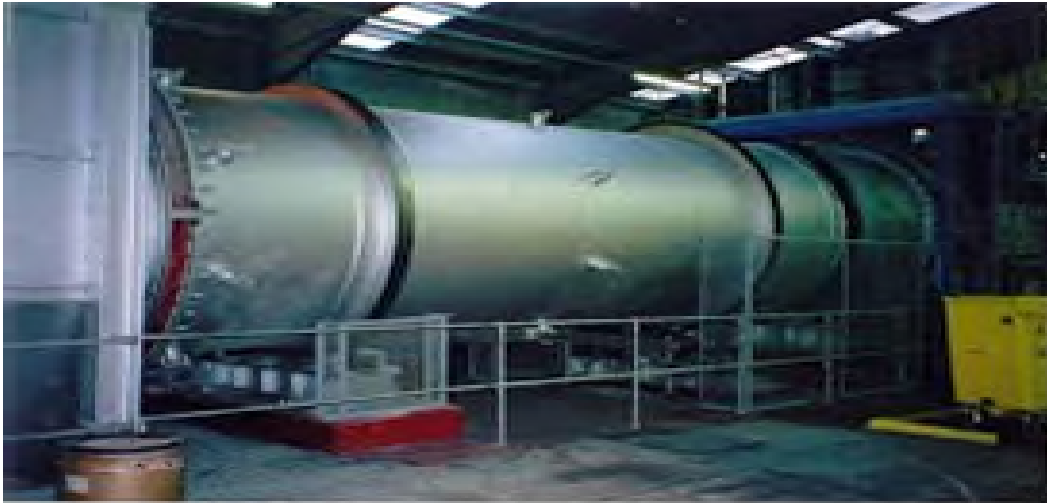
Figure I.4 : Incinérateur rotatif de capacité de 500 à 3000 Kg /h
