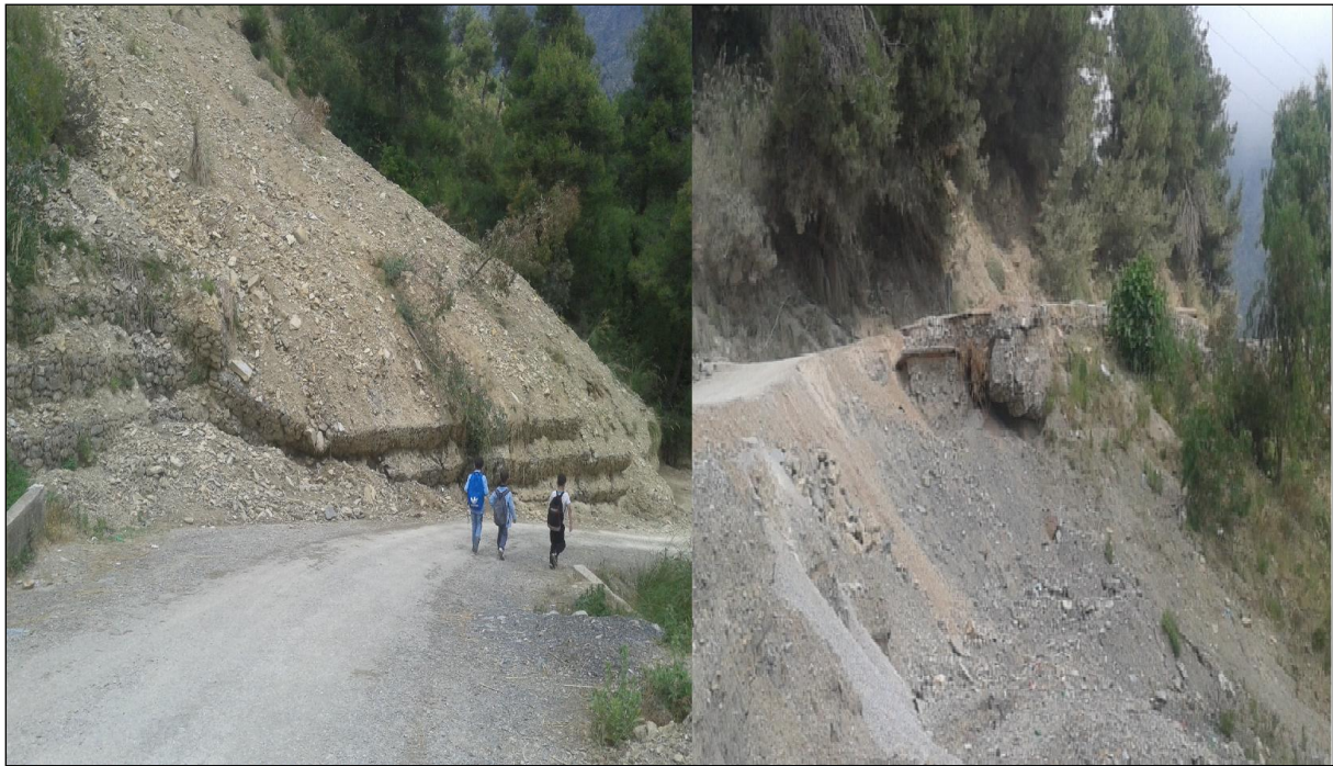
Figure 22 Photos prise sur site montrant la géomorphologie
