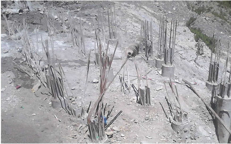
Figure 15 : Illustration montrant le clouage par micro pieux mixtes.
