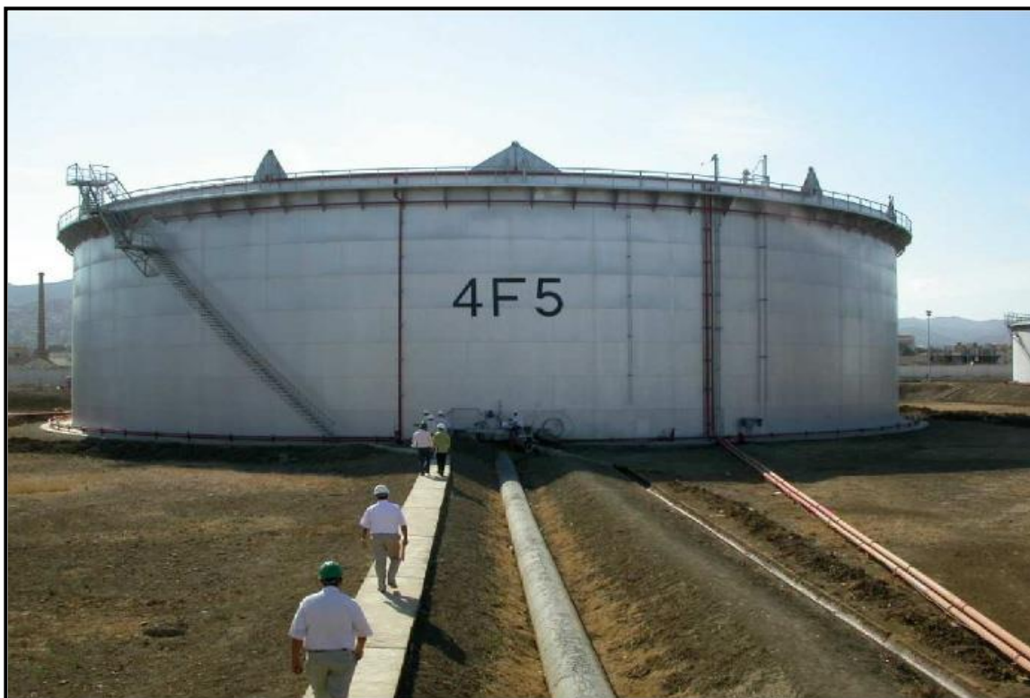
Figure I.2 : Vue du bac 4F5 du dépôt nord et sa cuvette de rétention [1]
