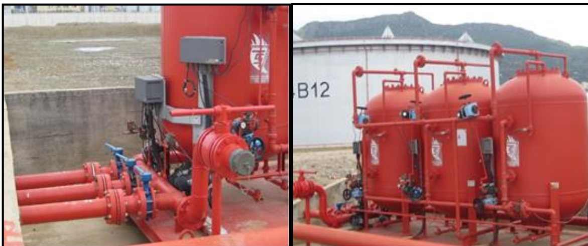
Figure I.8 : Unité de stockage et de dosage d'émulseur [1]
