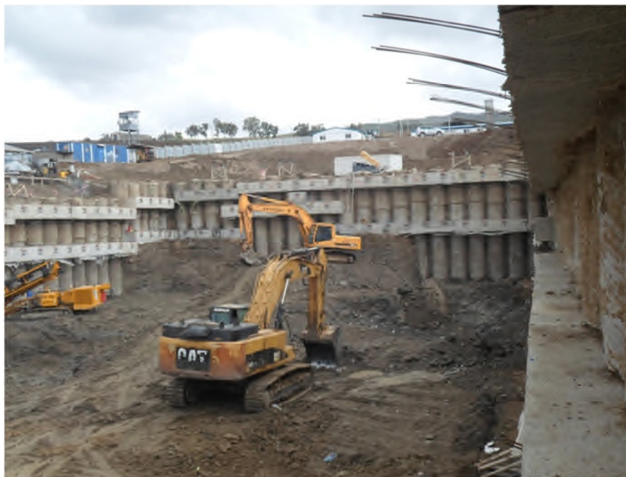
Figure II.9 : Stabilisation par pieux et tirants (portail nord du tunnel Pk9 Mila).
