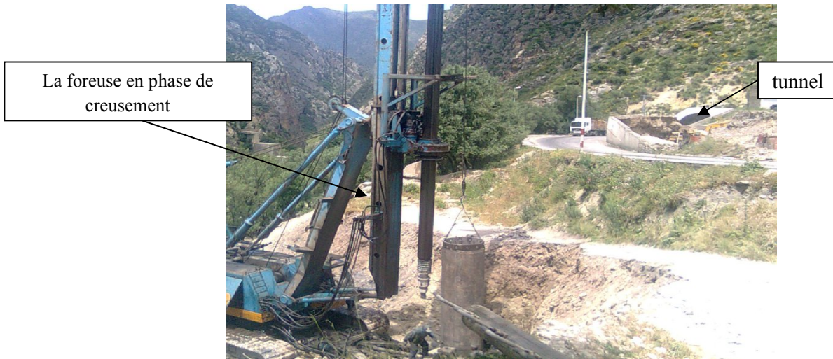
Photo 02: Le projet en cours de réalisation
