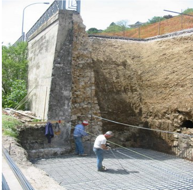
Photo 01 : Exemple d'un mur de soutènement en B.A avec une hauteur importante.
