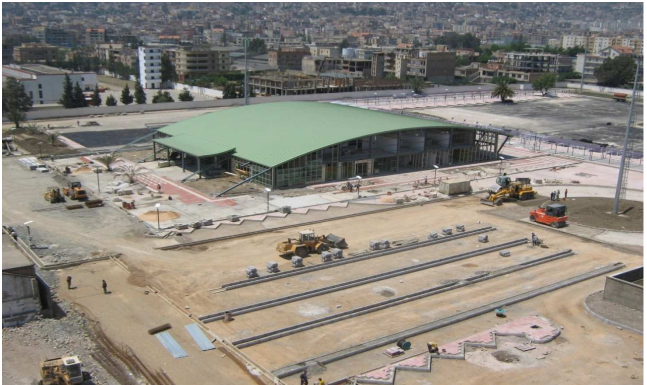
Figure 69 : La nouvelle gare routière de Béjaia en plein chantier (photo prise en juin 2010).
