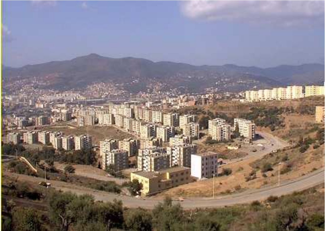
Figure 46 : La ZHUN (zone d'habitat urbain nouvelle) de Sidi Ahmed.
