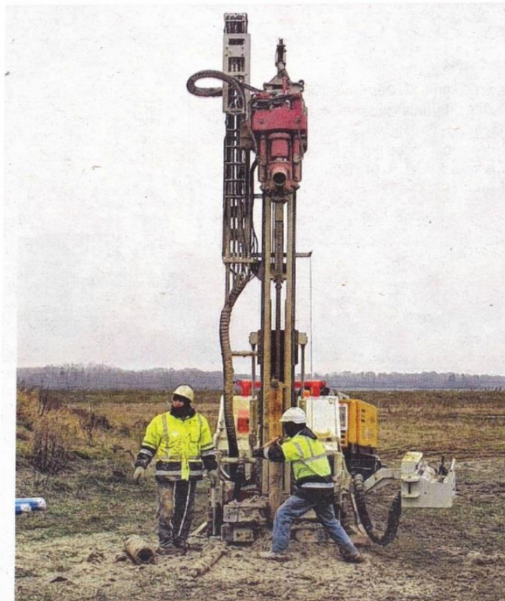
Jouarre, hier. Des ouvriers installent des piézomètres pour contrôler la qualité de l'eau dans le sous-sol et effectuent des travaux afin d'évaluer la densité du sous-sol. (LP/F. LÉ.)
