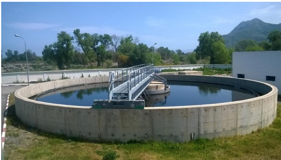
Figure I-8. Décanteur secondaire STEP SET.
