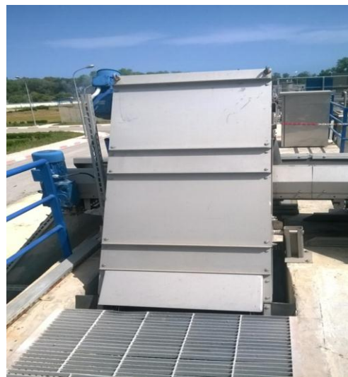
Figure I-4. grille mécanisée STEP SET.
