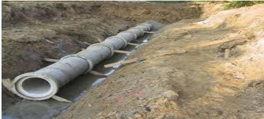
Figure V.2: Conduite en béton (buse)
