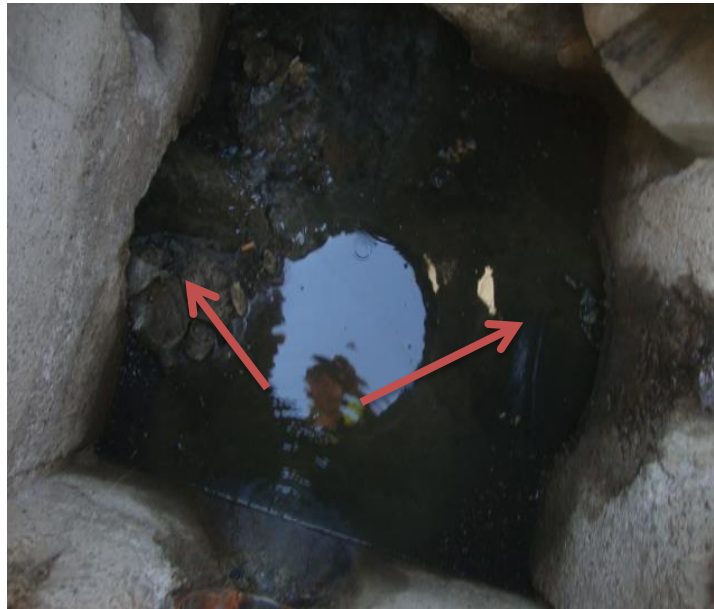
Figure II.4 : Photos de quelques regards
