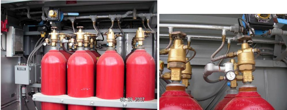
**Fig.III.7** : système de protection anti-incendie.
