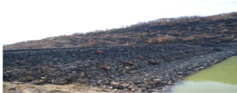
Exemple de talus amont protégé par riprap
