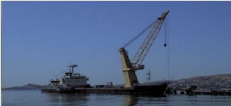
Figure I.11 : Maintenance d'une hydrolienne à l'aide d'un bateau
