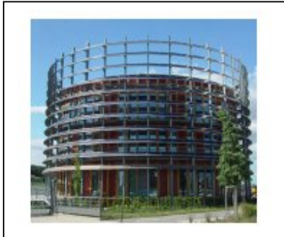
Structure en brise soleil
