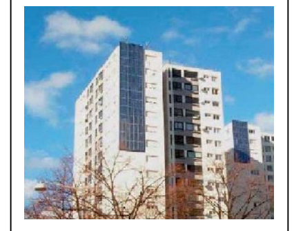
Structure en façade
