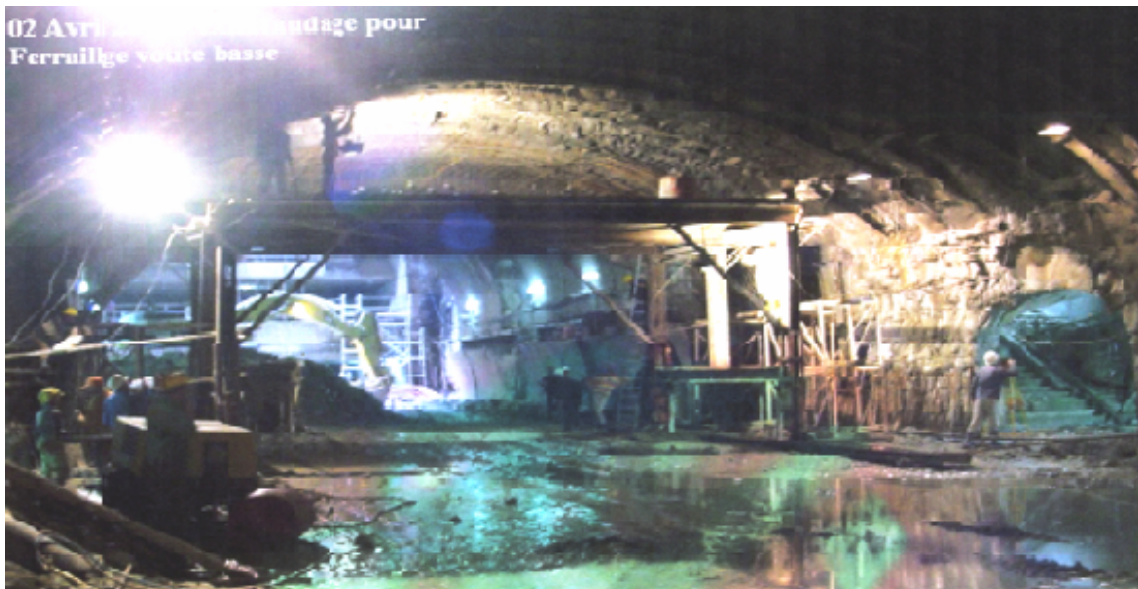
FIG. 3.4 – Echafaudage pour ferrailage de voûte tunnel (Hamma)
