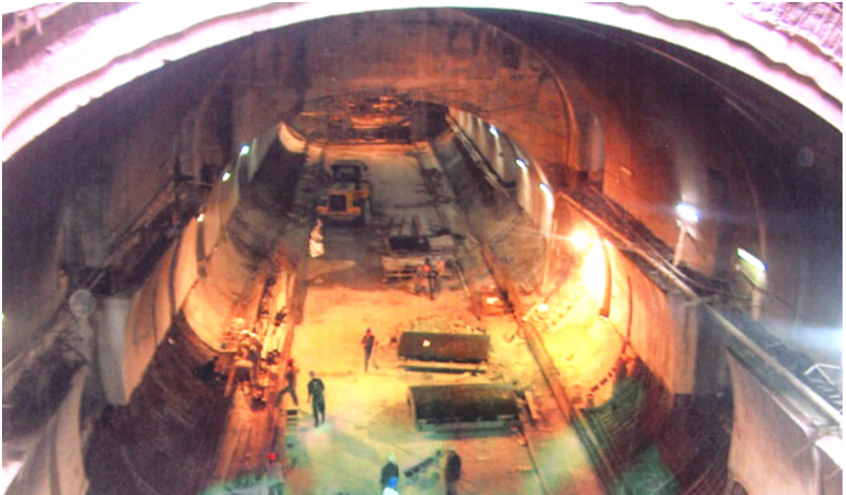
FIG. 3.6 – Revêtement définitif du tunnel (Hamma)
