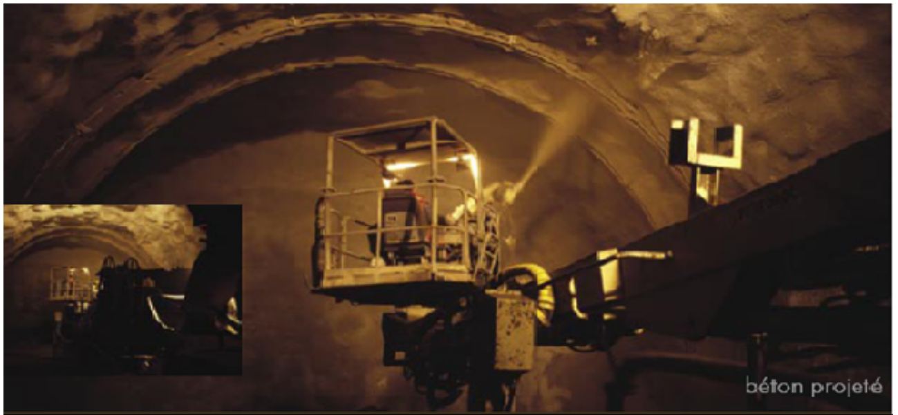
FIG. 3.5 – Mise en place du béton projeté
