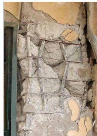
Fig.5.6 : Dommages subits par la structure
