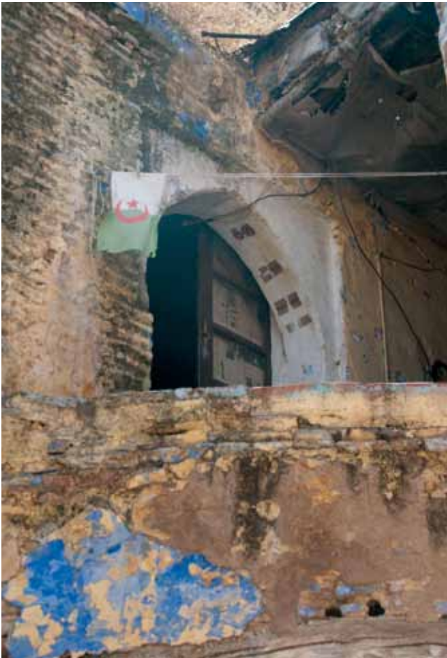
Le balconnet de la maison des Ibn Marzuk dans la Médina de Tlemcen
