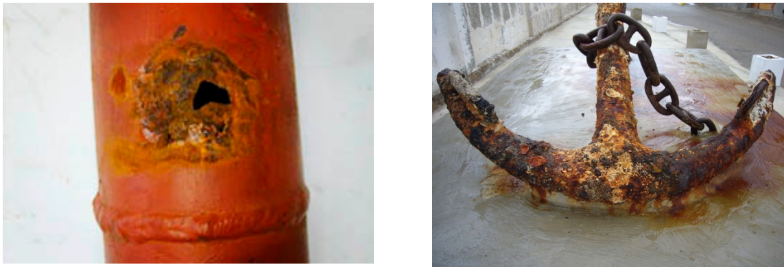
Figure I.1 : Photos de matériaux soumis aux phénomènes de corrosion.
