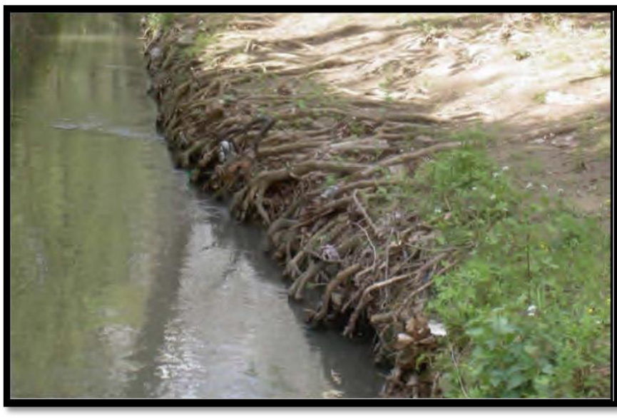
Figure 07 : Aménagement des berges de l'oued contre le glissement (Halouche. B, 2007).
