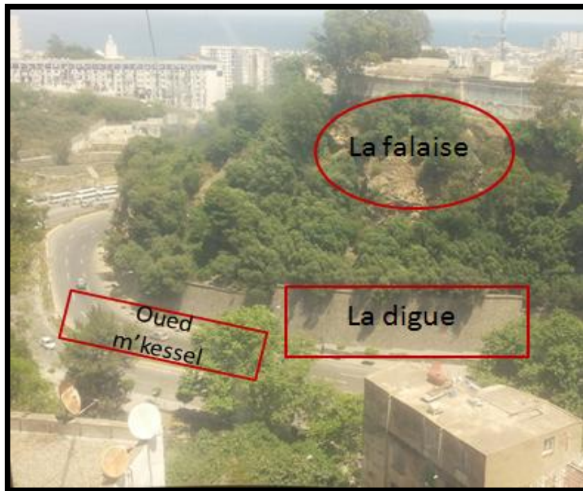
Figure 75 : photo montre la digue au niveau d'oued m'kessel.
