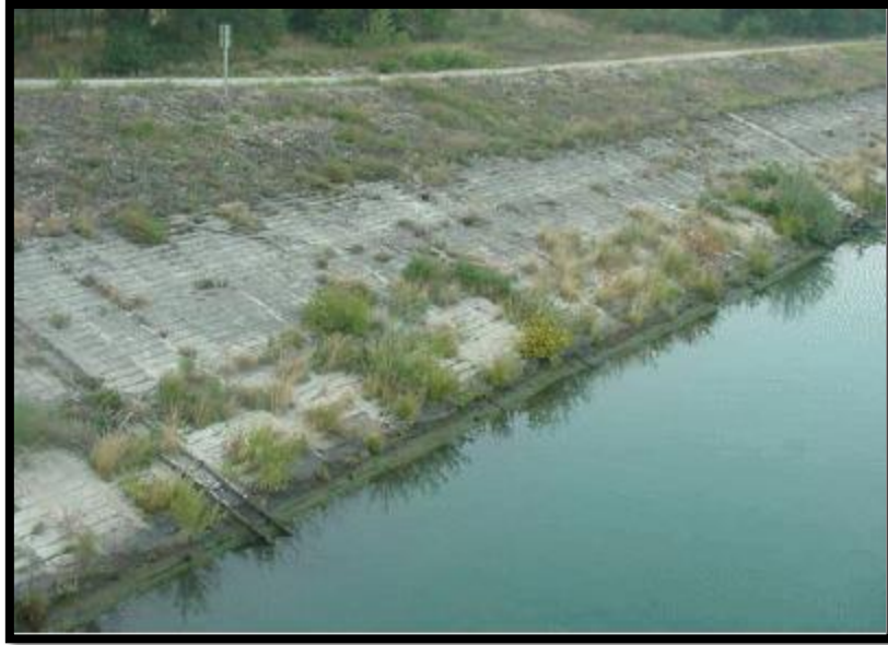
Figure 04: Digue de navigation du Rhône en charge en permanence (Mériaux. P, 2001).
