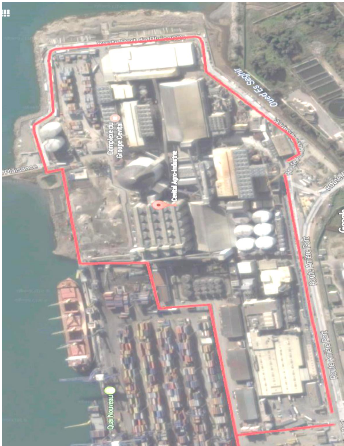
Figure I.1 : Situation géographique du complexe CEVITAL
