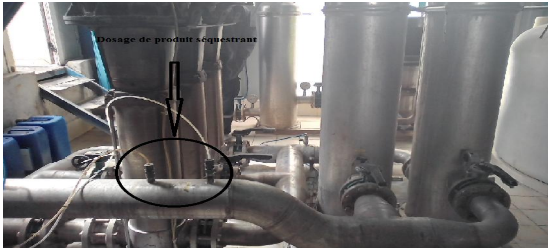
Figure II.1 : Photographie du dosage de produit séquestrant avant les filtres à cartouche.
