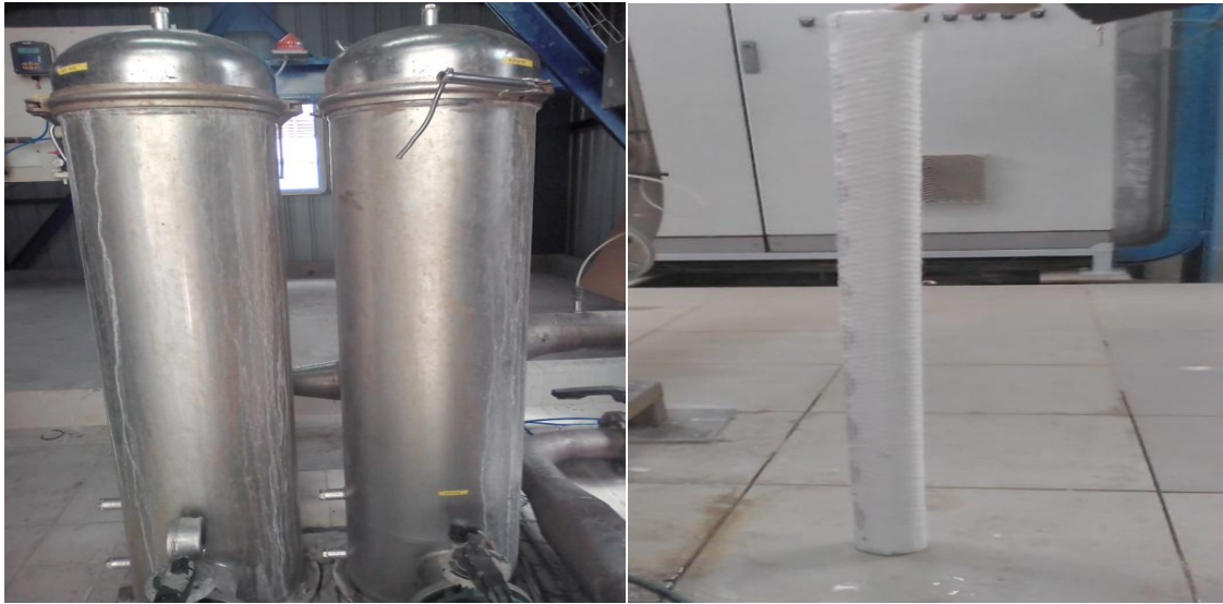
Figure II.2 : Photographie filtre à cartouche. Figure II.3 : Photographie la cartouche.
